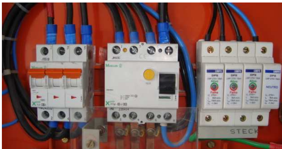
Figura 3 – Exemplo (disjuntor, dispositivo DR e DPS em quadro)
