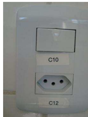
Figura 4 - Identificação de condutores, tomadas e interruptores
