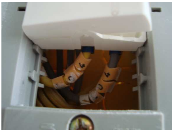
Figura 4 - Identificação de condutores, tomadas e interruptores
