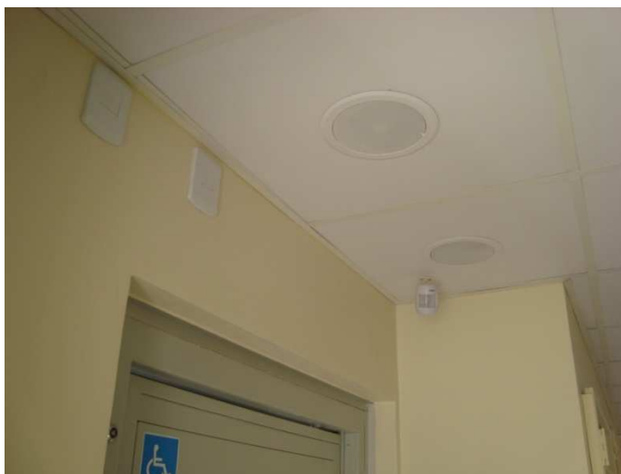
Figura 9 – Caixas acústicas em forro modular
