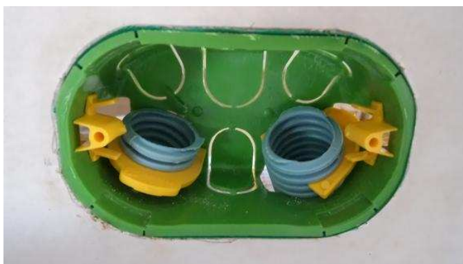
Figura 1 – Caixa de ligação para drywall
